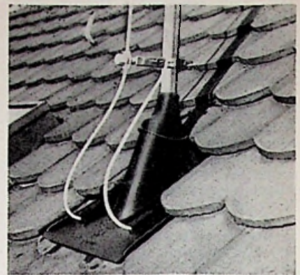
Dakafdekking met regenwerende kabelinvoer Dab50 van Hirschmann-Claessen
